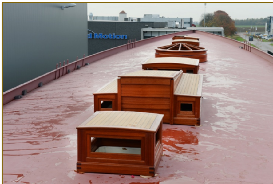
Tijdelijke opstelling van de dekhuizen
